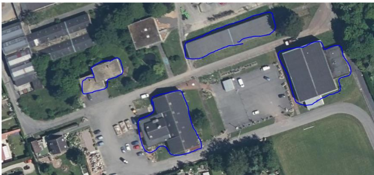
des 4 bâtiments de l'ANCIEN COLLEGE CURIE
