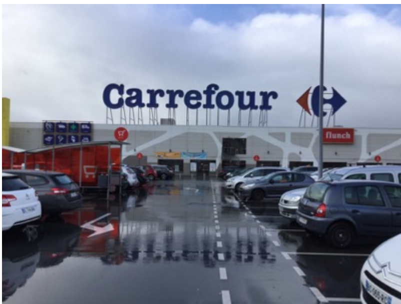
Enseigne sur toiture de grand format, zone commerciale de Liévin – rue Marie Liétard, novembre 2018
