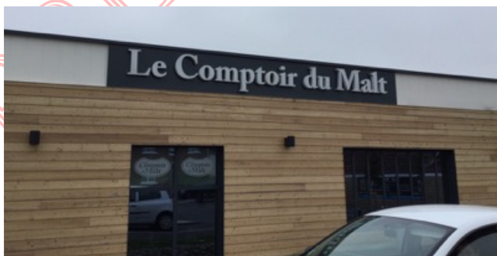
Enseignes parallèles au mur jouant sur le contraste, rue de l'Abregain, novembre 2018
